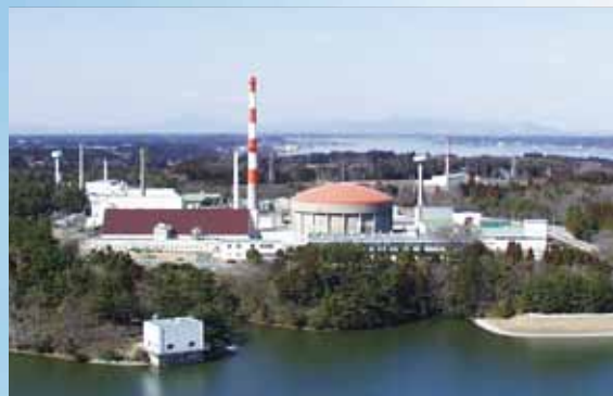
材料試験炉外観
