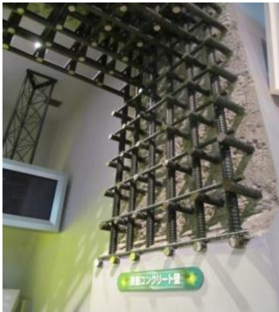
耐震性を高めるための 鉄筋コンクリート壁の実規模大模型 (日本原燃・六ヶ所PR館)
